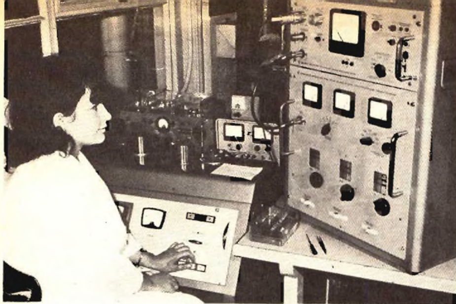
Fig. 4 - Controllo di un oscillatore a cristallo. Il quarzo montato nella sua unità viene fatto oscillare sulla sua frequenza esatta che viene controllata con continuità tramite il sintetizzatore. Dopo che il cristallo è montato su un oscillatore la deriva, dovuta ad invecchiamento, è controllata come spiegato nel testo.
