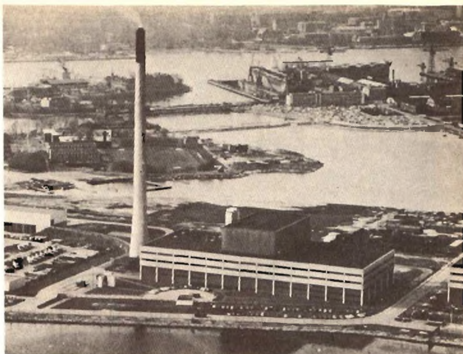
Fig. 31 - Un enorme forno d'incenerimento dei rifiuti fornisce il riscaldamento a buona parte della popolazione di Copenaghen.
