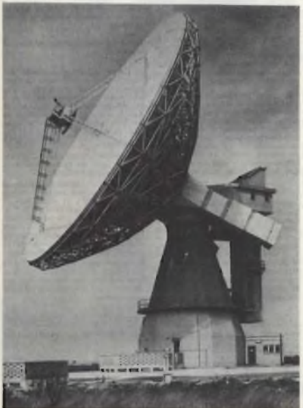
Fig. 4 - Un'antenna parabolica usata per la rete DEEP SPACE NETWORK rete per lo spazio lontano avente il diametro di 64 m, ed un peso complessivo di 7.260 tonn.
