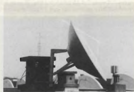
Fig. 5 - Esempio di antenna parabolica da impiegare per la ricezione della TV via satellite.
