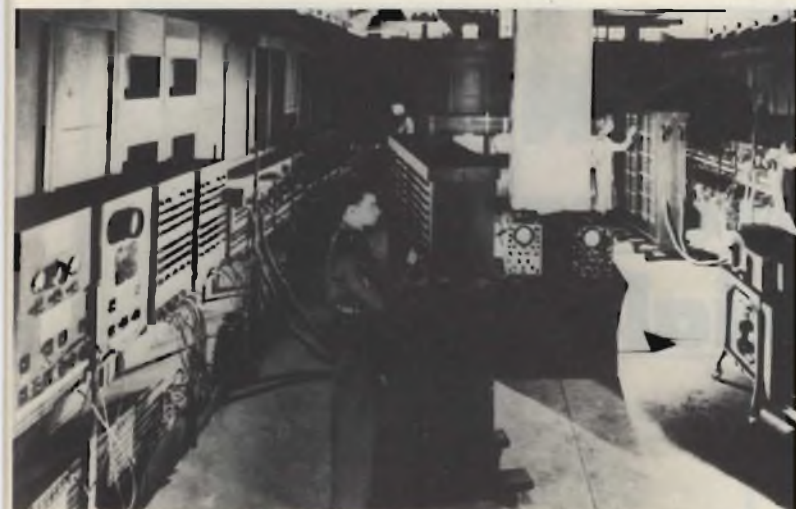
La fotografia mostra il primo computer elettronico digitale del mondo, chiamato ENIAC (dalle iniziali di Electronic Numerical Integrator and Computer). Questo computer fu completato per conto del governo degli Stati Uniti nel 1946. Nei computer che vennero progettati subito dopo l'ENIAC venivano impiegate migliaia di valvole.
