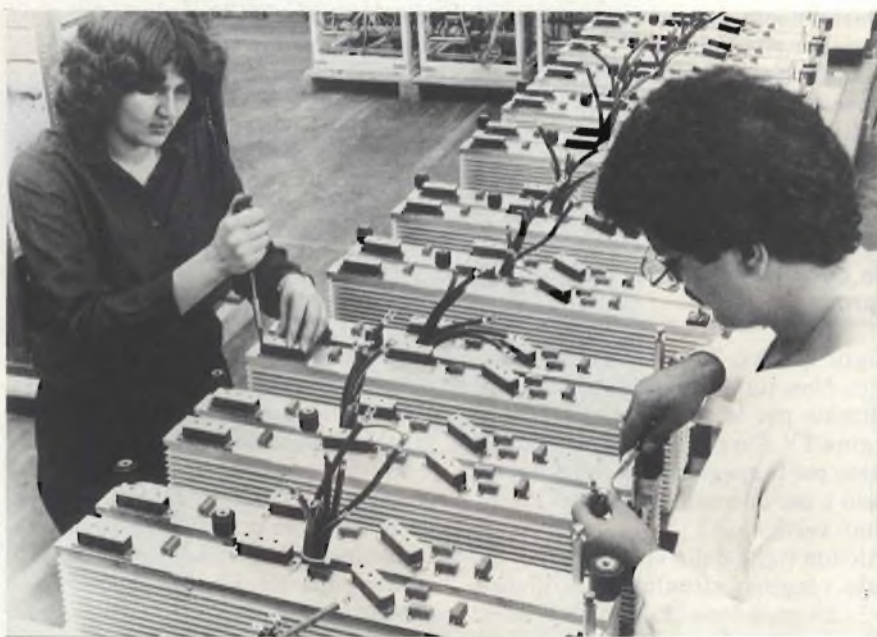
I gruppi di continuità statici sono composti da un raddrizzatore, da un inverter e da una batteria di accumulatori rigidamente collegata ad un circuito intermedio in corrente continua. Queste apparecchiature proteggono carichi privilegiati da mancanze di tensione di alimentazione e mantengono allo stesso tempo costanti i valori di tensione e di frequenza. La foto mostra il montaggio dei componenti dell'inverter nella fabbrica Siemens AG di Erlangen.
