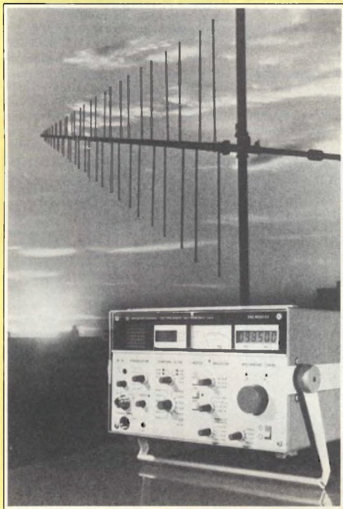
Misuratore dell'intensità di campo per impieghi professionali (da 20 a 1000 MHz). (Foto Rohde & Schwarz)
