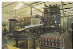
Impianto di resinatura degli statori.
