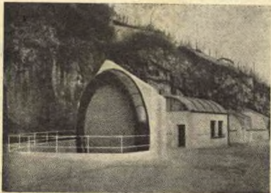
Ecco come appare, in una visione panoramica, il Tunnel del vento realizzato dalla Guzzi. E' questo il primo impianto del genere realizzato in Italia e, per il momento rimane l'unico a cui i nostri tecnici possono ricorrere.
