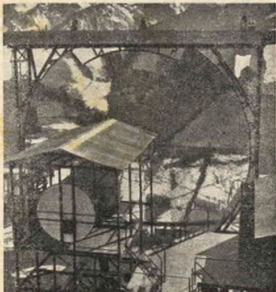
Fig. 5. — La grande installazione del laboratorio di Mont-Louis. Si notino ancora le dimensioni dello specchio parabolico in confronto del laboratorio postogli davanti.
