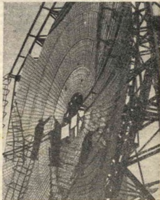
Fig. 6. — Questo è lo specchio solare di Mont-Louis composto da oltre 7000 specchi, per una superficie totale di 90 mq. Tale specchio, concentrando i raggi del sole, dà le possibilità di ottenere temperature superiori ai 4000°. Della grandezza e della complessità di questa realizzazione ci si renderà meglio conto, paragonandola agli uomini che appaiono al centro dello specchio stesso.
