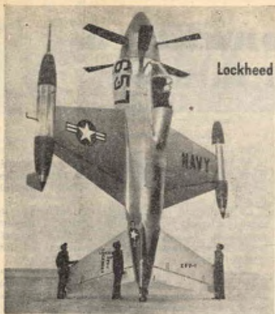
Fig. 2 - Il Lockheed, libero dai tralici del carrello, si mantiene verticale poggiando sulle estremità delle ali a croce.
