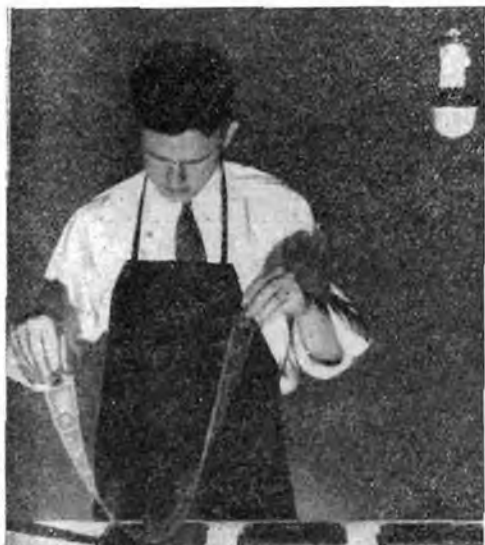
Fig. 15. — Afferrando la pellicola alle due estremità la faremo scorrere, con moto continuo e uniforme, in continuazione nel bagno di sviluppo per la durata di circa 10 minuti.
