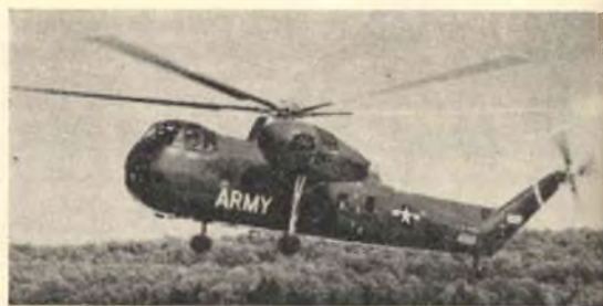
Fig. 5. - L'elicottero d'attacco tipo SIKORSKY S 56, in dotazione alle Forze di terra e di mare americane. Dotato di un portello anteriore di carico, può alloggiare nel suo capace ventre materiale per una complessiva portata di ben 5 tonnellate (tre veicoli leggeri o 26 uomini perfettamente equipaggiati).
