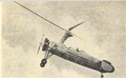
Fig. 2. - Dopo i primi tentativi naufragati di costruzione dell'elicottero, sembrò imporsi l'auto-giro — una via di mezzo fra aeroplano ed elicottero — col quale il costruttore, a dimostrazione delle caratteristiche del suo elaborato, riuscì ad attraversare la Manica nel 1928.
