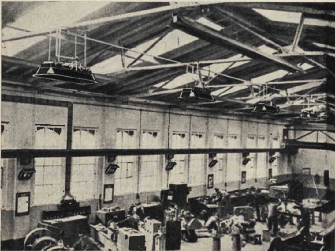
Fig. 2 - Per il conseguimento di una razionale diffusione del calore in locali di lavoro, si sistemeranno i diffusori a soffitto e alle pareti.
