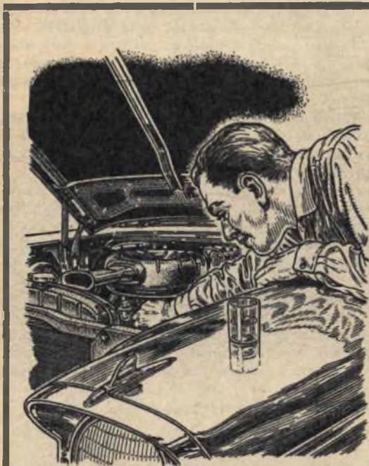
Un bicchiere riempito per metà di acqua, sistemato sulla carrozzeria in prossimità del motore, ci sarà di valido aiuto nella messa a punto del carburatore.
