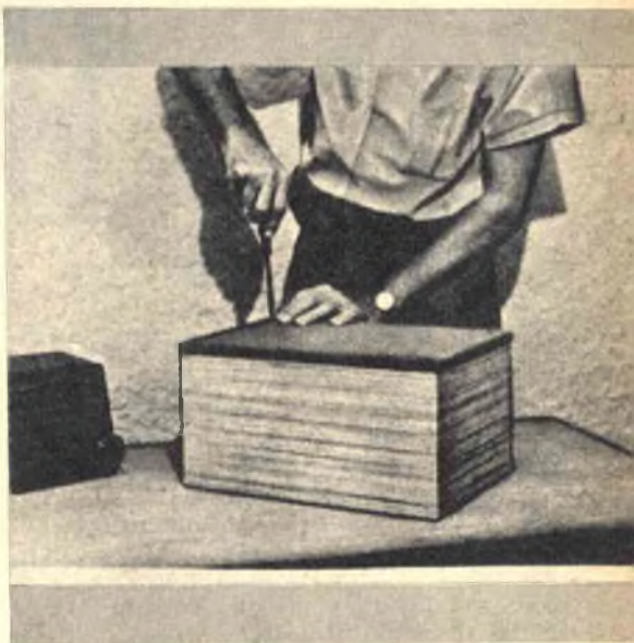
Fig. 3 - Il pannello frontale viene ricoperto con tela per altoparlanti, al fine di proteggere il cono dell'altoparlante dalla polvere e rendere presentabile il mobile.
