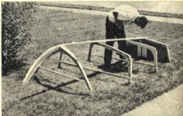
**Fig. 3** - La costruzione dello scheletro della barca è il primo lavoro da eseguire. Preparate quindi le quattro ordinate e la trave di chiglia si inizierà il lavoro di incollatura e inchiodatura delle parti.
