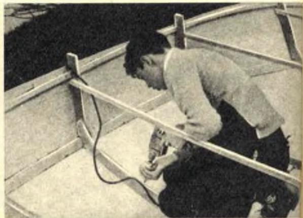
**Fig. 5** - Non lesinate con viti e chiodi nelle operazioni di fissaggio delle parti ricordando che la rigidità e la solidità della barca dipendono in gran parte dalla perfezione del lavoro di inchiodatura e incollatura.
