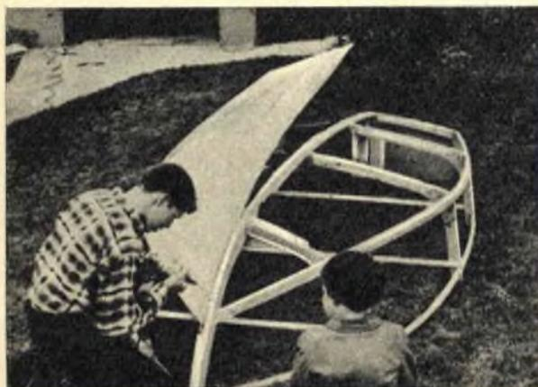
**Fig. 4** - Lo scheletro va ricoperto nel fondo e ai fianchi con legno compensato di ottima qualità che risulti resistente all'umidità. Non riuscendo ad incurvare meccanicamente il legno si ricorrerà all'incurvatura a fuoco.
