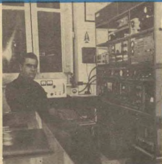
Fig. 2 - La stazione di DL 6 PI è un vero modello di ordine e perfezione. Il ricevitore è collocato davanti al posto dell'operatore, alla cui destra è il trasmettitore; gli altri apparecchi sono alimentatori per le apparecchiature e modulatori. Si notino il tasto telegrafico semiautomatico, l'elenco internazionale dei radioamatori di tutto il mondo e, appese alla parete di fondo, le cartoline di conferma dei collegamenti ricevute dai corrispondenti: Filippine... Nuova Zelanda... Groenlandia... Isole del Pacifico...
