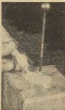
Il conduttore va bloccato con zolfo fuso
