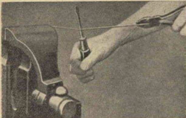
Fig. 1 - Raddrizzamento di uno spezzone di filo
