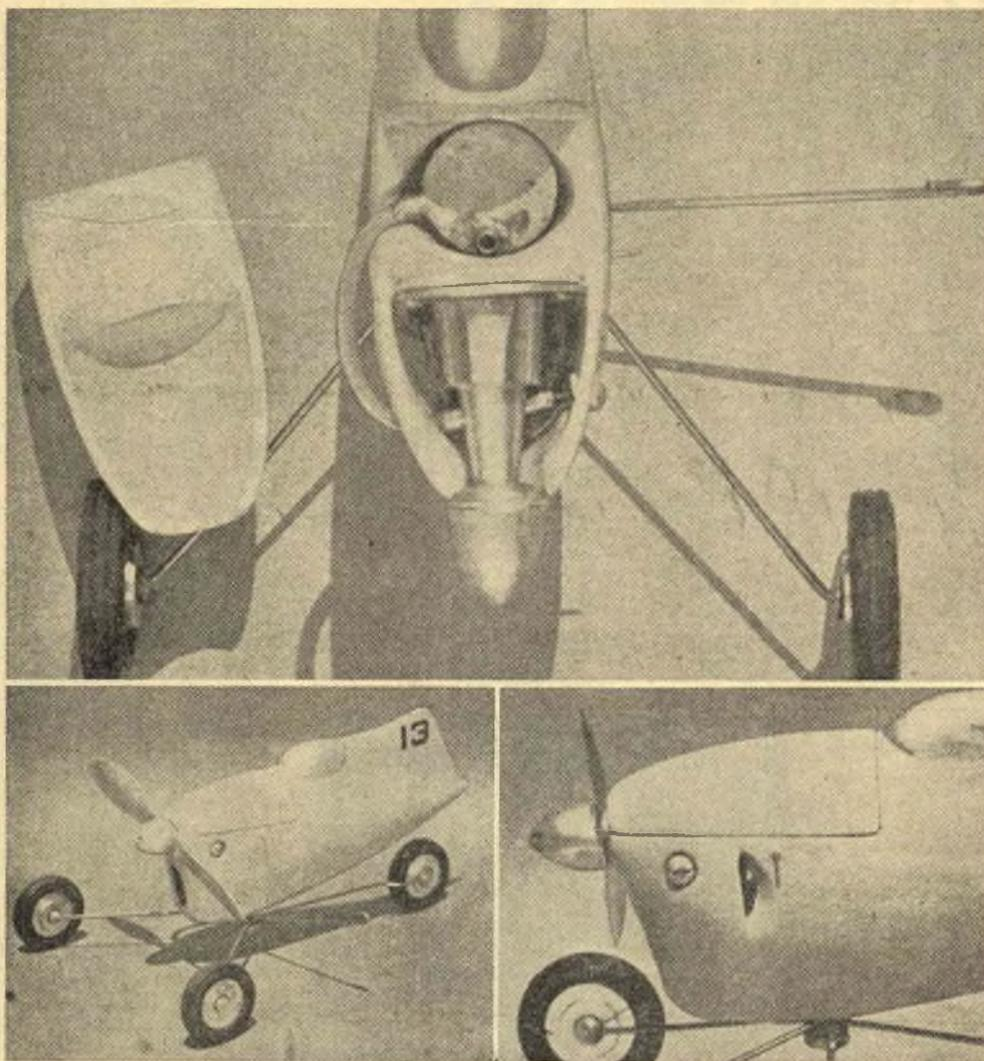
A sinistra il modello completo, pronto a sfrecciare sulla pista. A destra, la parte anteriore mostra l'attacco del carrello. In alto la sistemazione del motore e del serbatoio.
