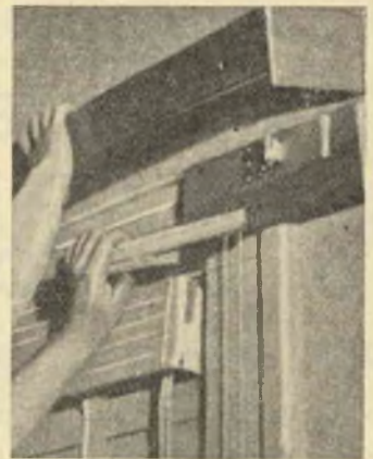
Nulla di più semplice della messa in opera della cornice ultimata: bastano pochi minuti
