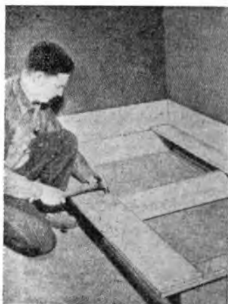
La struttura inferiore è ultimata fissando le due fiancate e le due testate alla base.
