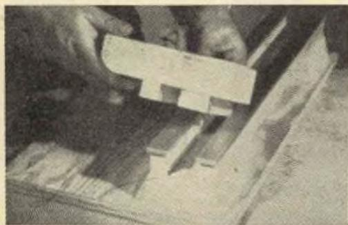
**LA TESTATA** è assicurata al letto mediante due blocchi di pino a cavallo della guida posteriore ed un'unica lunga vite avvitata nel blocco che fa base. Tre viti, affogate e limate, tengono a posto le strisce di alluminio.
