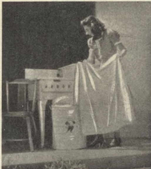
Sistemazione del cuscino e della coperta di lana che dovranno impedire ogni perdita di calore.
