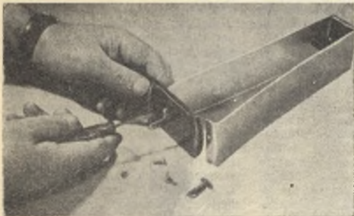
FOTO A SINISTRA - Svitare le due bananine da una normale spina per corrente e centrarle con attenzione sull'isolatore che sostiene gli elettrodi depuratori.
