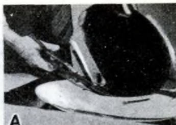
Prima di tagliare le pareti laterali e le altre parti del proiettore, conviene realizzarne i modellini in carta, a grandezza naturale.
