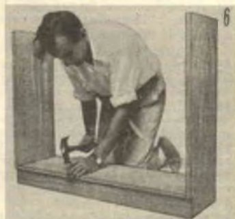
Successivamente, si inchiederà il fondo anche alle pareti laterali; con questa unione reciproca, la costruzione della libreria risulterà quanto mai robusta, senza esigere affatto la realizzazione di complessi incastri o di altri sistemi di unione tra le parti che la compongono.
