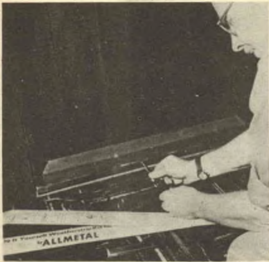
Foto a sinistra - Un facile sistema per eliminare gli spiragli esistenti sul bordo inferiore di una porta è quello che prevede l'uso di una speciale striscia di feltro sporgente da un profilato a "C", in acciaio. Questa guarnizione, come è ovvio, va fissata al bordo inferiore della porta. Disegno a destra - 1) Veduta particolareggiata del sistema illustrato nella foto precedente; 2) Sistema identico a quello del particolare 1, coadiuvato da una striscia elastica di metallo, fissata sulla faccia opposta del bordo inferiore della porta; 3) Uso di un particolare tipo di soglia, che va in sostituzione della soglia originale della porta, oppure al di sopra di questa, o direttamente sul pavimento; 4) veduta particolareggiata di questo speciale tipo di soglia.
