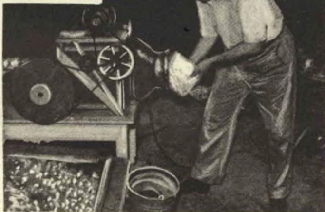
Caricamento della betoniera: per avere la certezza di rispettare le proporzioni tra i vari ingredienti, si preferisca misurare questi, invece che giudicarne la quantità ad occhio. — (In alto): Sistemazione all'interno del bidone, delle tre lame dell'agitatore.
