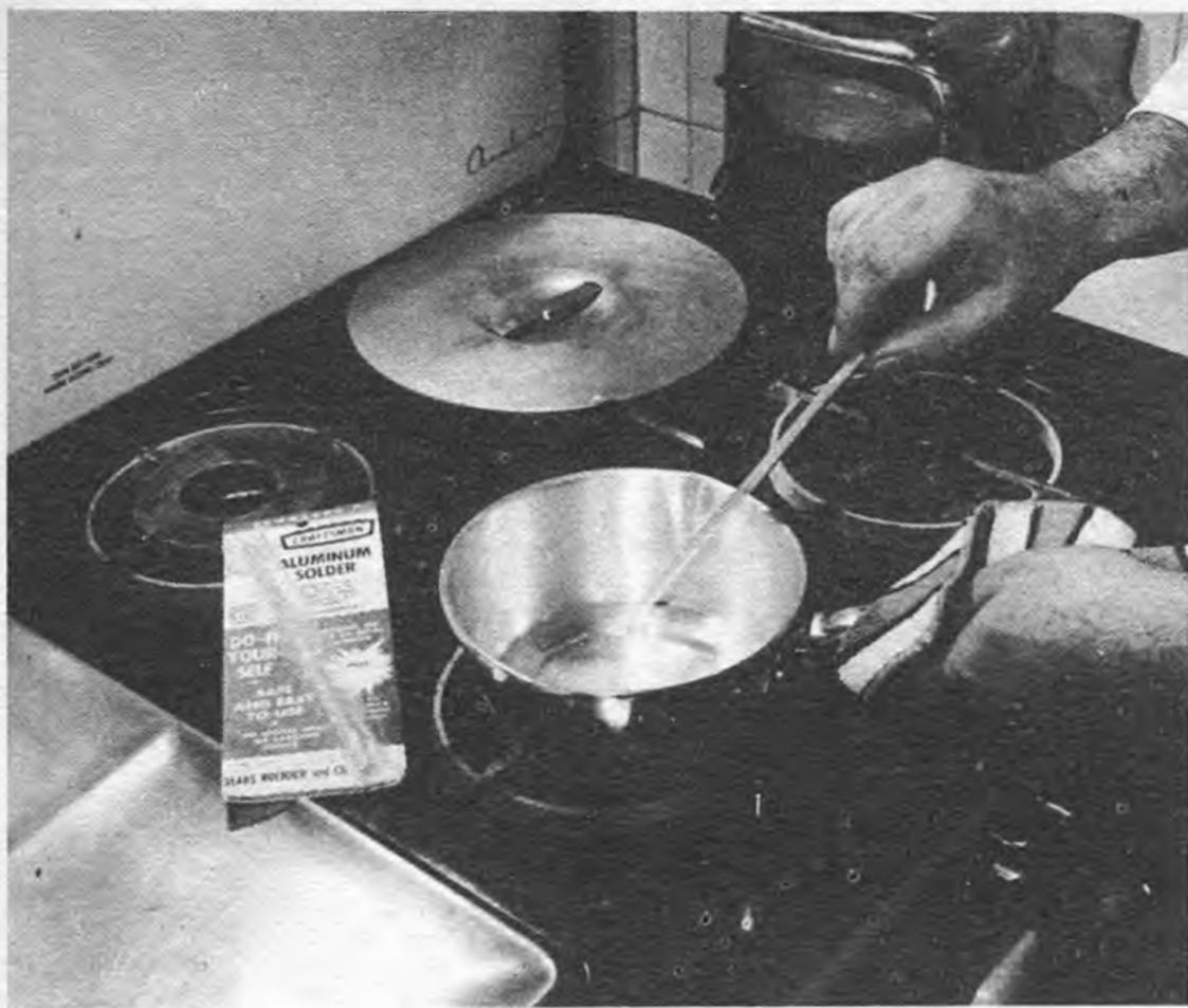
Nulla di più frequente, in casa che il problema della riparazione di un foro in un utensile da cucina in alluminio. La riparazione ne è semplicissima: pulitura scrupolosa dell'interno e dell'esterno del recipiente, riscaldamento di questo sulla mezza fiamma di un fornello a gas ed applicazione, sul foro, della bacchetta della speciale lega saldante. La riparazione è anche possibile su tubi, barre, bacchette, profilati, angolari, ecc. di alluminio.
