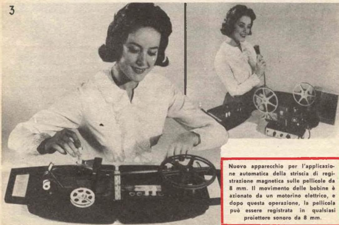
Nuovo apparecchio per l'applicazione automatica della striscia di registrazione magnetica sulle pellicole da 8 mm. Il movimento delle bobine è azionato da un motorino elettrico, e dopo questa operazione, la pellicola può essere registrata in qualsiasi proiettore sonoro da 8 mm.
