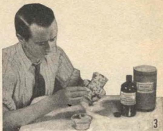
**OGGETTI DI PORCELLANA ROTTI, possono essere riparati con mastice ottenuto mescolando insieme carbonato di calcio, e gesso precipitato, e silicato di sodio. Applicare il prodotto sulle superfici di rottura, premete insieme i pezzi da cementare e asportate l'eccesso di mastice con cencio umido.**
