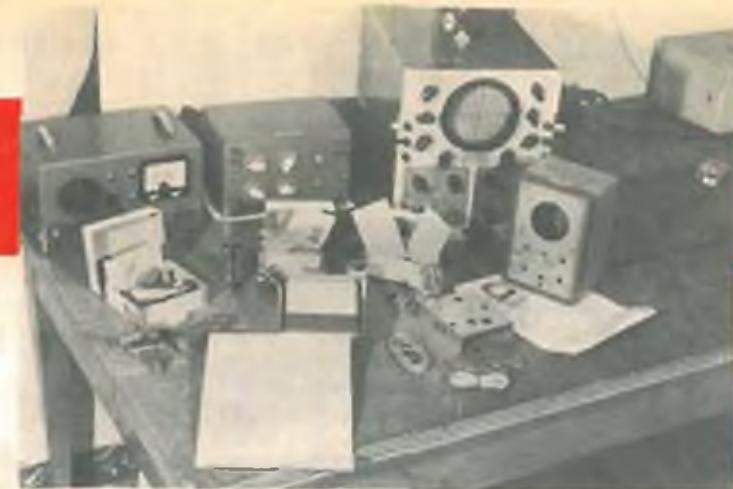
Il materiale per la costruzione del Voltmetro EICO 222 disposto sul tavolo prima dell'inizio del montaggio. Oltre a tutti i componenti necessari alla costruzione, la scatola contiene un manuale per il montaggio, un manuale d'istruzioni per l'uso dello strumento e per la ricerca di eventuali difetti di montaggio, e un cartellino di garanzia.
