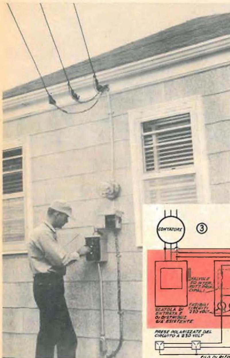
Se l'entrata della forza motrice è a tre conduttori ed il sistema a bifase, potrete normalmente disporre di forza motrice per un quadro di distribuzione secondario. I circuiti esistenti vengono lasciati indisturbati ed il nuovo quadro deve portare l'interruttore generale, le valvole, le cassette di derivazione a 115 e 230 volt, in base al numero dei circuiti desiderati. Il diagramma sopra riportato rappresenta uno schema generico.
