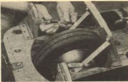
**Due tenditori permettono la regolazione dei cavi del freno e del motore. Questa deve essere fatta dopo il montaggio.**
