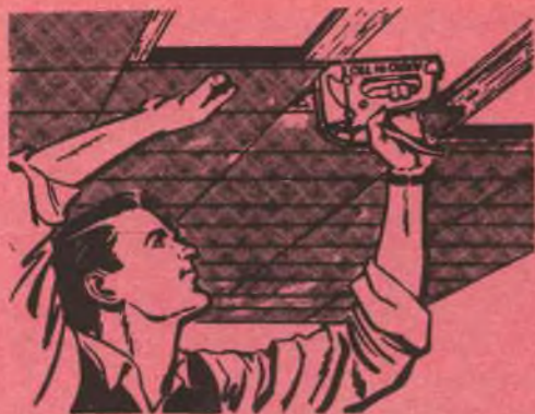
Posa di un soffitto decorativo.
