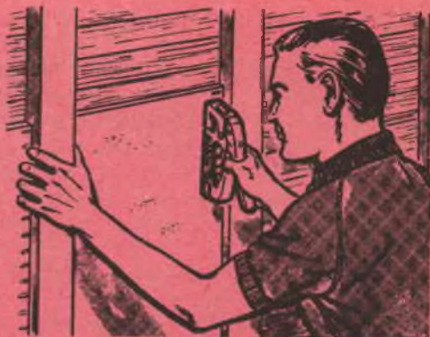
Installazione di pannelli isolanti.
