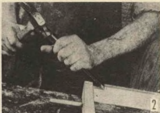
FOTO 1) Tutti i giunti sono assicurati con colla e viti o tondini di rinforzo da 12 mm. piantati per 20 mm. in fori ciechi in ciascuno degli elementi del giunto stesso. FOTO 2) Una tacca nel telaio coperschio serve a trattenere sicuramente sollevato il coperchio durante l'uso della vasca
