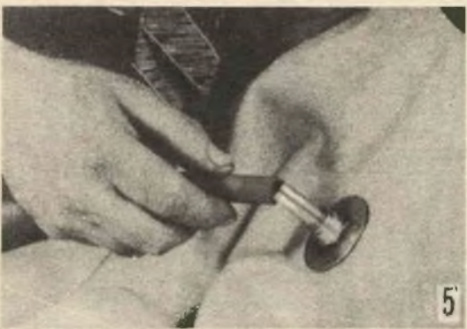
FOTO 5) Connessione del tubo all'attacco di metallo; una legatura del tubo stesso con filo di rame medio, assicura la unione ed impedisce al tubo di sfuggire facilmente. FOTO 6) Unione del bordo superiore della vaschetta nei due lati maggiori, al bordo della parte superiore della struttura portante, per mezzo di una cucitura con filo di lino. Notare la funicella viene usata durante la cucitura e durante l'uso per mantenere le due strutture portanti alla corretta spaziatura
