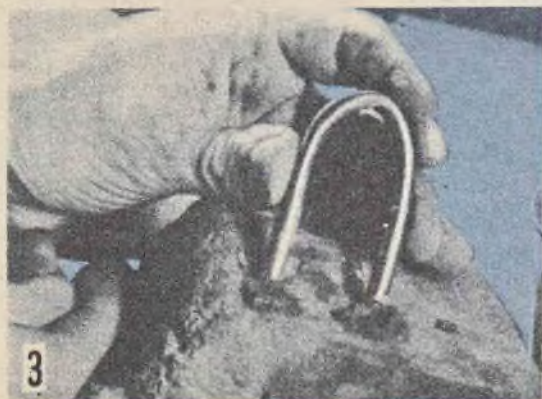
(A sinistra): Dopo avere riempito a metà, i fori, con del gesso impastato con acqua ed un poco di silicato di potassio, si introduce la «U» di ferro od acciaio, in precedenza preparata. — (A destra): Schema di funzionamento del dispositivo di cui al disegno B
