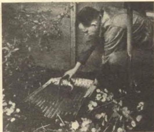
Per evitare che l'acqua che cola dal tetto si fermi in prossimità delle fondamenta della abitazione determinando un accumularsi di umidità se non guasti peggiori, è possibile realizzare una sorta di guida che convogli l'acqua stessa lontano dalla abitazione; si tratta di scavare il terreno alla profondità di 6-10 cm. quindi stendere l'ondulato in tale cavità, in modo che le sue scanalature siano orientate non parallelamente
