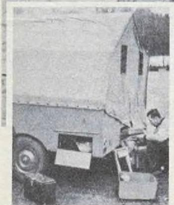
Osservare come negli sportelli degli scompartimenti ricavati nella profondità del baulino, in prossimità delle ruote, possano trovare posto gran parte della attrezzatura per il campeggio; la restante viene poi lasciata nell'interno del bauletto, una volta che questo sarà richiuso; notare anche le bordature di protezione contro le infiltrazioni di pioggia.
