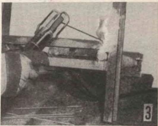
Saldatura lungo le linee di contatto tra i quattro elementi che compongono la base della pressa.
