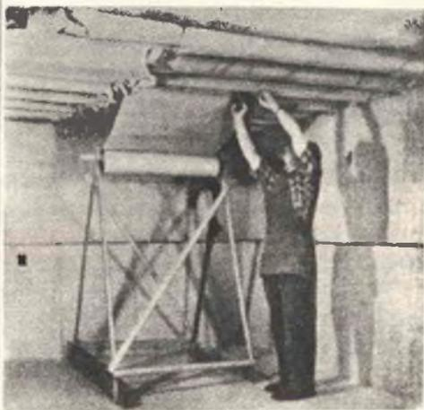
**FIG. 12 - i muri anti-sonori devono essere costruiti con molta cura. Le giunzioni dei vari strati di materiale afonico devono essere sfalsate.**
