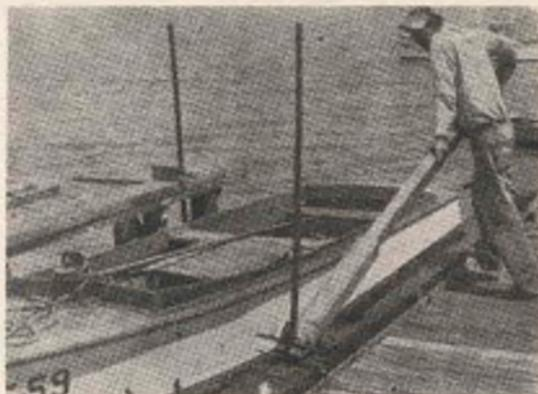
Per convenienza, i fori possono essere del diametro di mm. 20 e possono essere spazati 70 mm. circa; se è una sola persona che aziona l'elevatore, occorrerà che alternativamente, vada ad agire sui vari bracci verticali del traliccio, in maniera da sollevare uniformemente la imbarcazione alla altezza voluta mantenendola sempre allo stesso livello.
