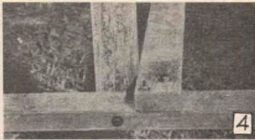
FOTO N. 4). Unione tipica di tre elementi: l'elemento da 120 cm posa su quello da 180 cm, le assi formanti la piattaforma sono quindi posate sugli elementi da 120 cm.
