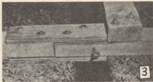
FOTO N. 3). Ova interessi disporre anche di una terza piattaforma, occorre applicare sulle strutture preesistenti, una struttura aggiuntiva, unendola per mezzo di coppie di piastre di metallo o di legno in funzione di giunti, ancorate con bulloni passanti e ben serrati
