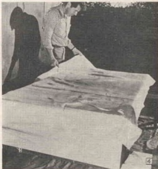
Il rettangolo di ovatta di fibra di vetro, è disteso sul fondo della barca capovolta, dopo avere applicato su questo una mano di vernice protettiva a catalizzazione; le misure debbono essere tali per cui un bordo di almeno 10 cm. di ovatta, ricada tutt'interno su tutti i lati dello scafo, con esclusione della estremità di prua, dove questo non occorre
