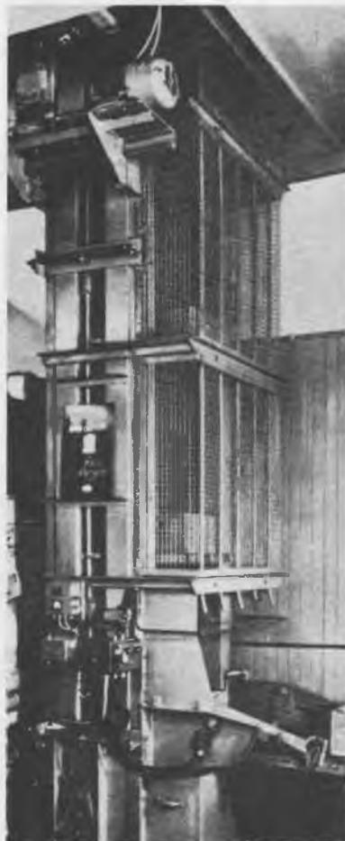
Dato che le strutture portanti (piatti) si mettono da sole in posizione verticale quando non sono cariche, si ottiene un notevole risparmio di spazio; lo spazio in pianta occupato dal trasportatore risulta appena maggiore della dimensione massima del carico sollevato. Vengono prodotti cinque tipi normali di dimensioni variabili da 38 x 33 cm a 127 x 104 cm, e per portare variabili da 22,7 a 1815 Kg.
