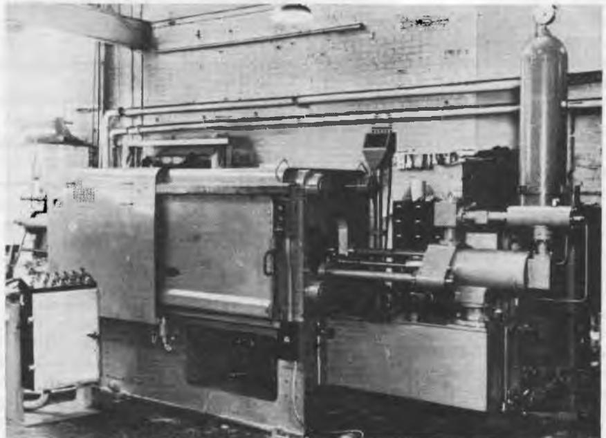
hampton ed è in grado di produrre pezzi pressofusi del peso fino a 2,27 kg in alluminio e fino a 6,8 kg in ottone. Ha una potenza di bloccaggio della matrice di 300 tonnellate ed è munita di un recentissimo impianto di controllo che consente la produzione di pezzi pressofusi di precisione.
