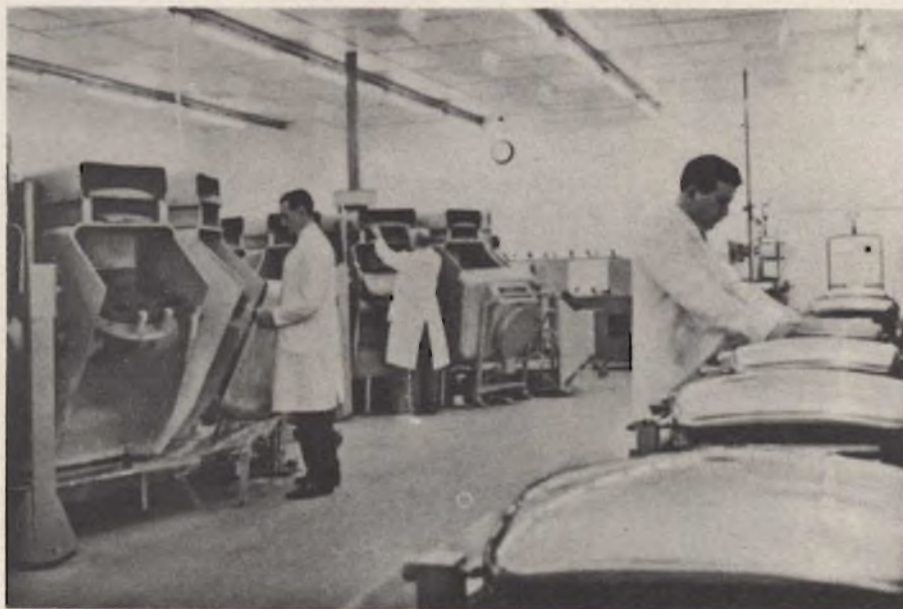
Fig. 9 - Fase di montaggio di un cinescopio per TVC.
