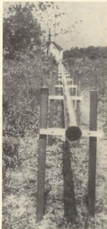
Fig. 16 - Deposizione della prima linea telefonica sperimentale mediante guide d'onda centimetriche, eseguita nel 1933.
