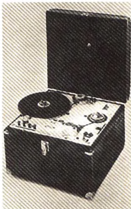
Fig. 2 - Il Magnetophono o «Tonschreiber» come si presentò al tecnico statunitense J. Mullin in quel Luglio del 1945.
