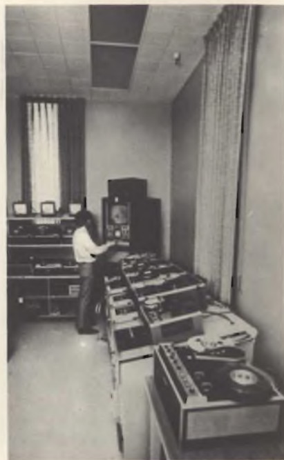
Manutenzione degli apparati RUM presso la Hewlett-Packard.
