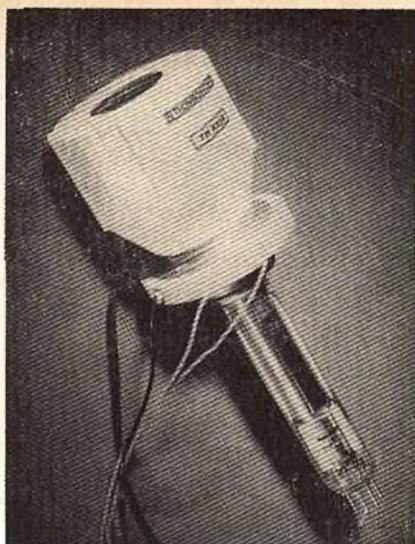
Fig. 2 - Fotografia illustrante il nuovo tubo per telecamera modello Esicon THX 538.
