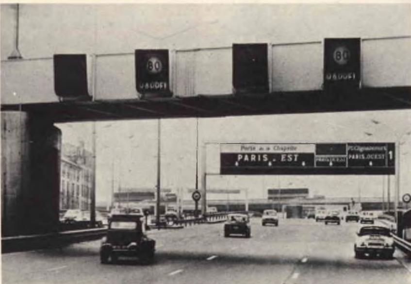
Fig. 11 - Esempio di segnaletica autostradale di rallentamento, realizzata mediante l'impianto radar su di un'autostrada francese.
