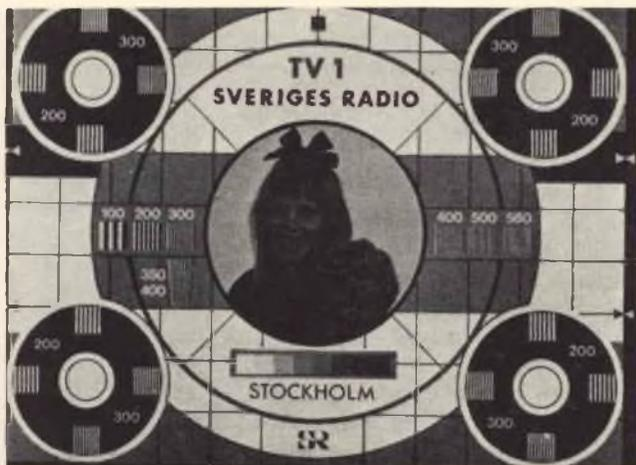
Fig. 5 - Monoscopio usato per le emissioni a colori dalla Sveriges Radio (Svezia).
