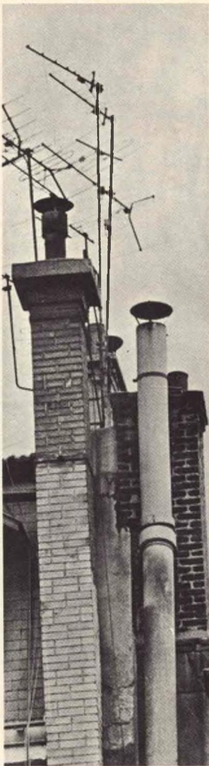
Fig. 4 - Esempio tipico di installazione multipla in un fabbricato nel quale ciascun utente dispone del suo proprio impianto di antenna. In questi casi, è molto probabile che si verifichino fenomeni in interferenza, anche a seguito dell'eventuale irradiazione di una parte del segnale ad opera dell'oscillatore locale di uno dei ricevitori funzionanti nello stabile, col grave rischio di compromettere la ricezione da parte degli altri utenti.
