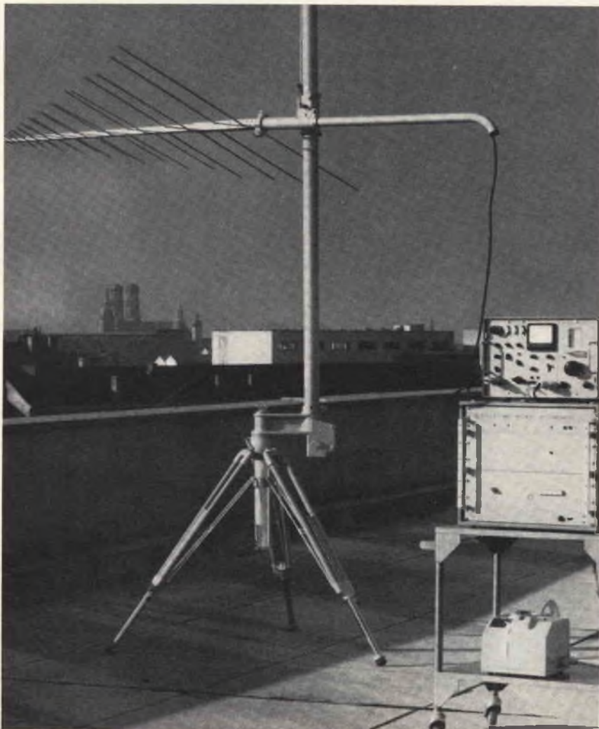
Fig. 4 - Apparecchiature per misure di campo em nella gamme VHF-UHF con antenna del tipo mostrato in figura 2, della Rohde & Schwarz.
