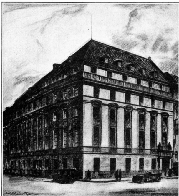
FIG. 2.—HAUS DES VEREINES DEUTSCHER INGENIEURE IN BERLIN.
