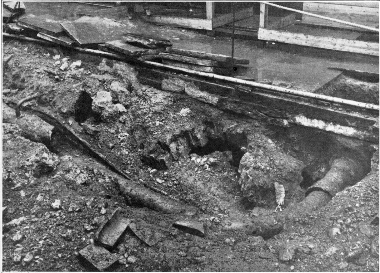
FIG. 6.—BEND ON GAS MAIN.
