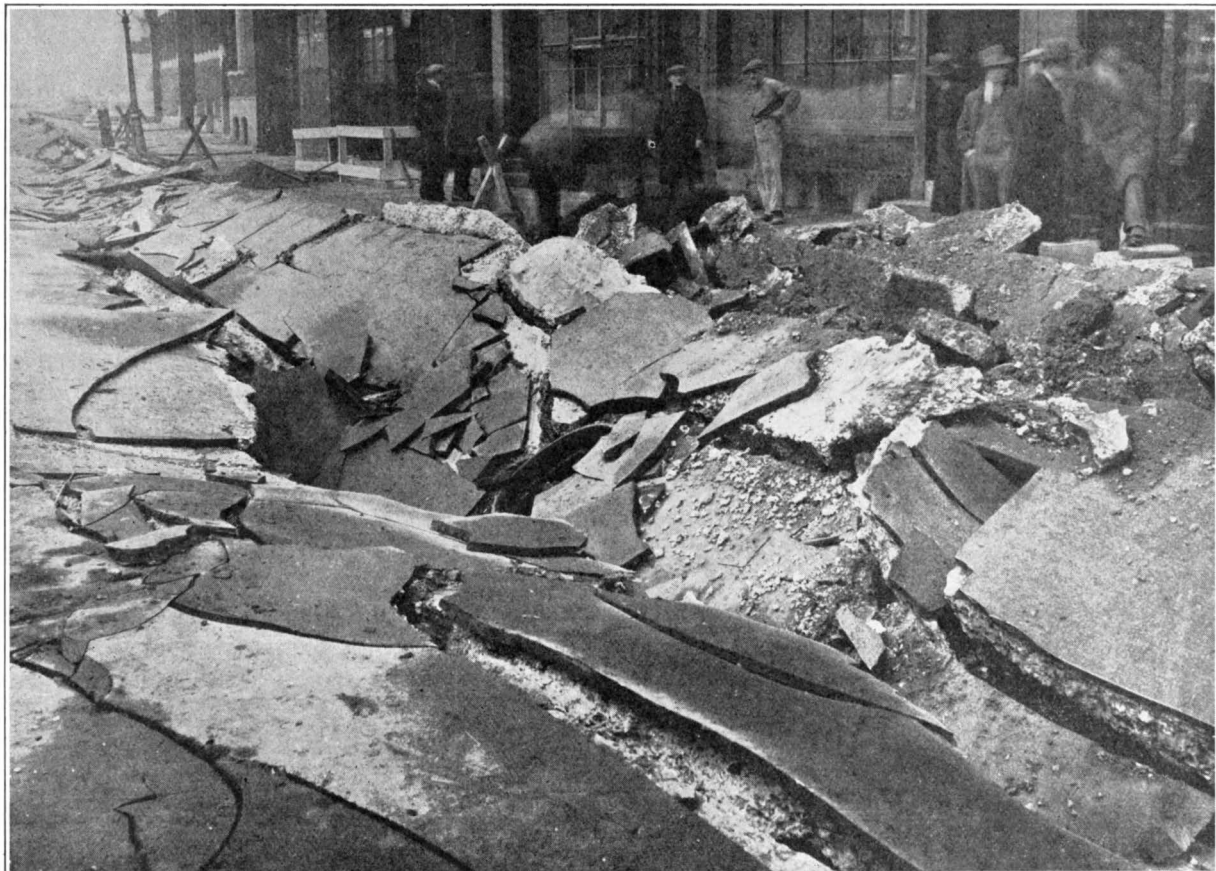
FIG. 6.—BEND ON GAS MAIN.
