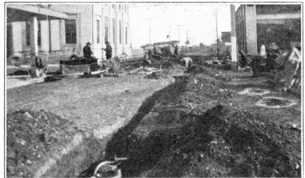
FIG. 10.—REPAIRING BLENHEIM UG. CABLE.
